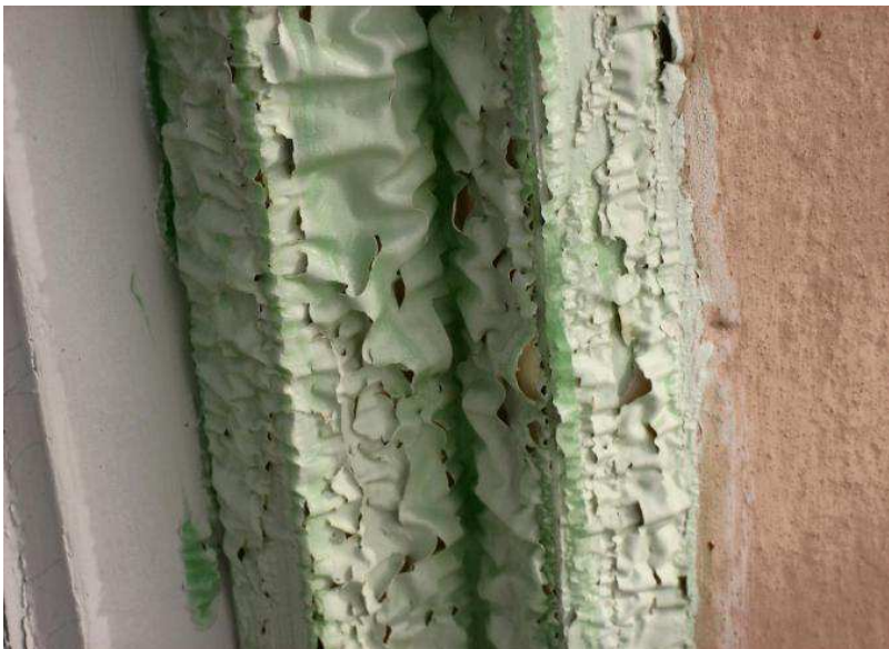
Abb. 1: Fensterrahmenbeschichtung nach mehrstündiger Einwirkung des Abbeizers (Bildnachweis: Denkmalpflege Hans Ritt, Untergriesbach)
