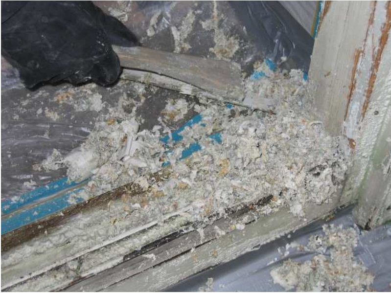
Abb. 2: Staubarmes Abschaben der angelösten Fensterrahmenbeschichtung (Bildnachweis: Denkmalpflege Hans Ritt, Untergriesbach)
