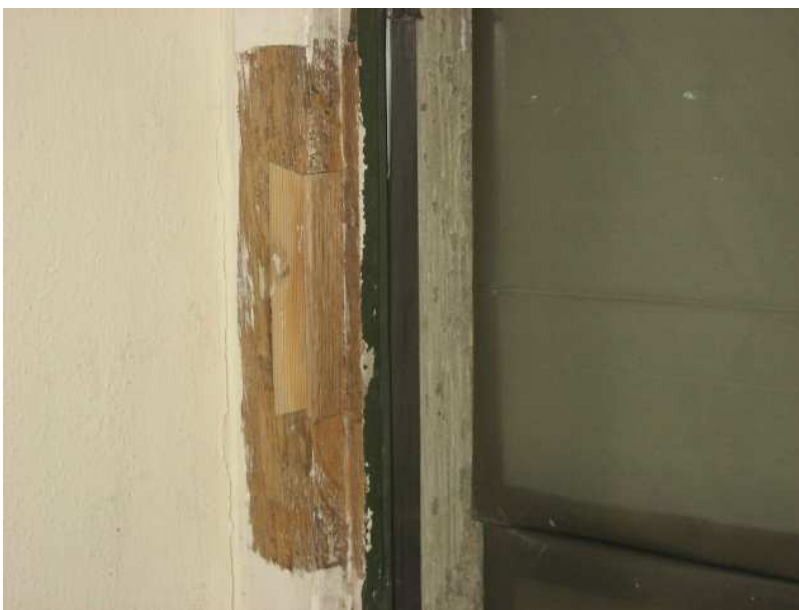
Abb. 3: Holzreparatur nach vollständiger Beschichtungsentfernung (Bildnachweis: Denkmalpflege Hans Ritt, Untergriesbach)
