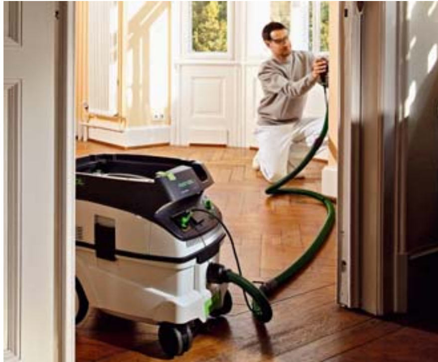
Für den Anschliff bleihaltiger Altbeschichtungen sollten nur ausgewählte Schleifmaschinen in Kombination mit einer Absaugung eingesetzt werden.
