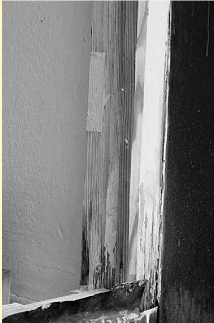
Abb. 2: Fensterstock während des Versuchs einer thermischen Entfernung bleihaltiger Anstriche
