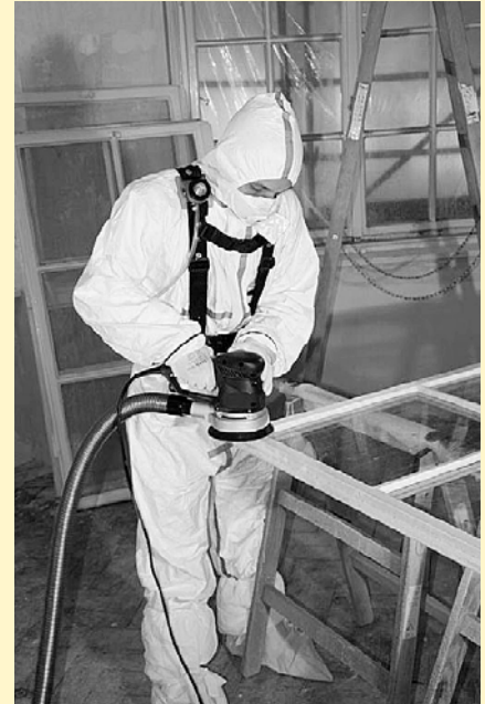
Abb. 4: Personenbezogene Messung beim abrasiven Entfernen bleihaltiger Anstriche von Fensterflügeln
