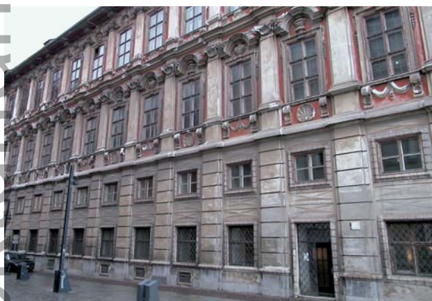
Jede Menge Fenster warten auf die Sanierung: Hausfassade in Graz
